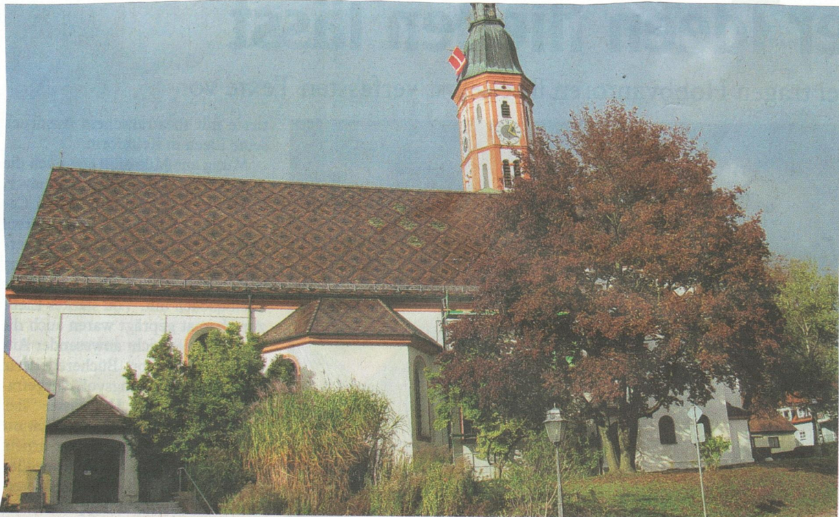
Der Dachstuhl der Kirche St. Michael in Mering ist so stark beschädigt, dass nun auch die Dachziegel abgedeckt werden müssen. Für mehrere Jahre wird ein Gerüst innen und außen das Bild der Kirche bestimmen.
