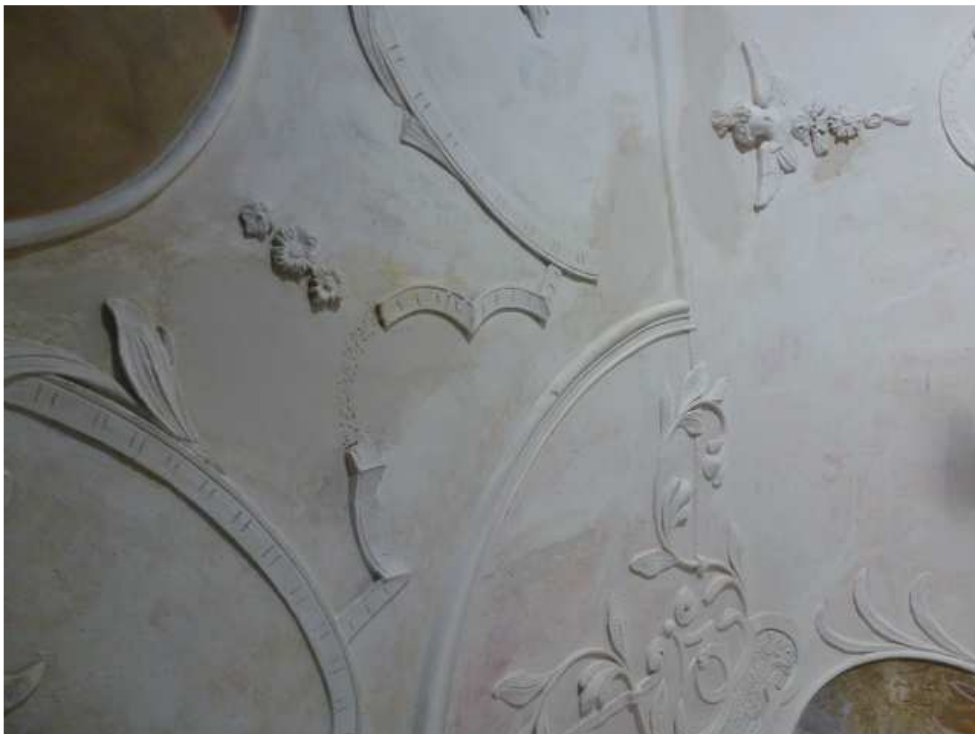
Abb. 2.12: Aufgeraute Fläche für Stuckierung
