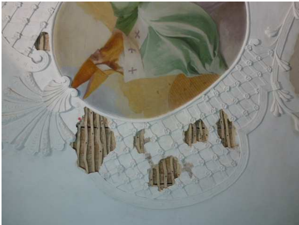
Abb. 5.1: Abnahme zerstörter Putze
