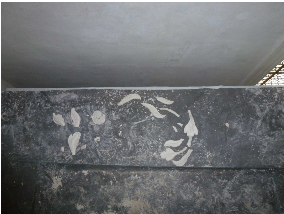
Abb. 4.4: Abgenommene Teile auf Gerüst abgelegt
