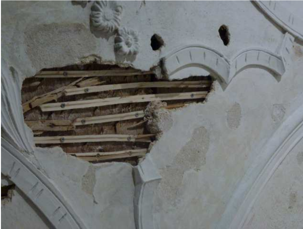
Abb. 2.3: Teilergänzung Putzträger
