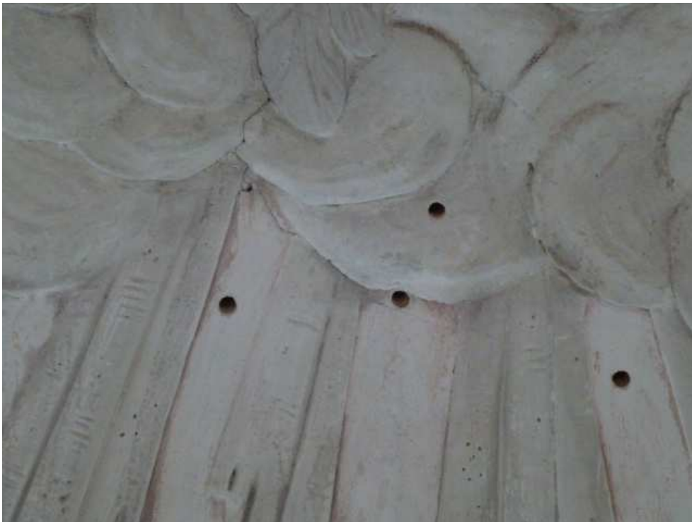
Abb. 1.2: Bohrlöcher für Hinterfüllung
