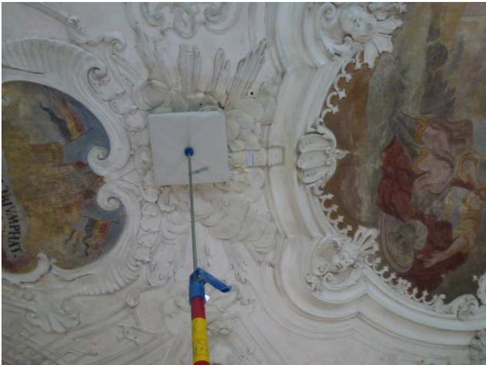
Abb. 1.4: Deckenabstützung
