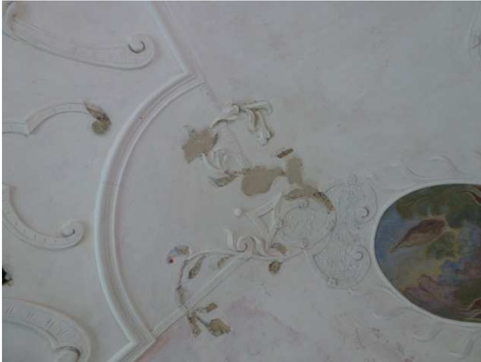
Abb. 4.9: geschlossene Fehlstellen
