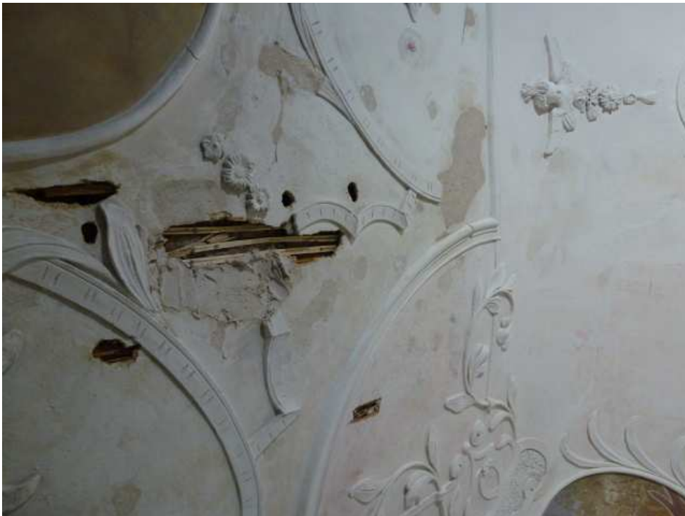
Abb. 2.4: Grundputz: Haarkalkmörtel
