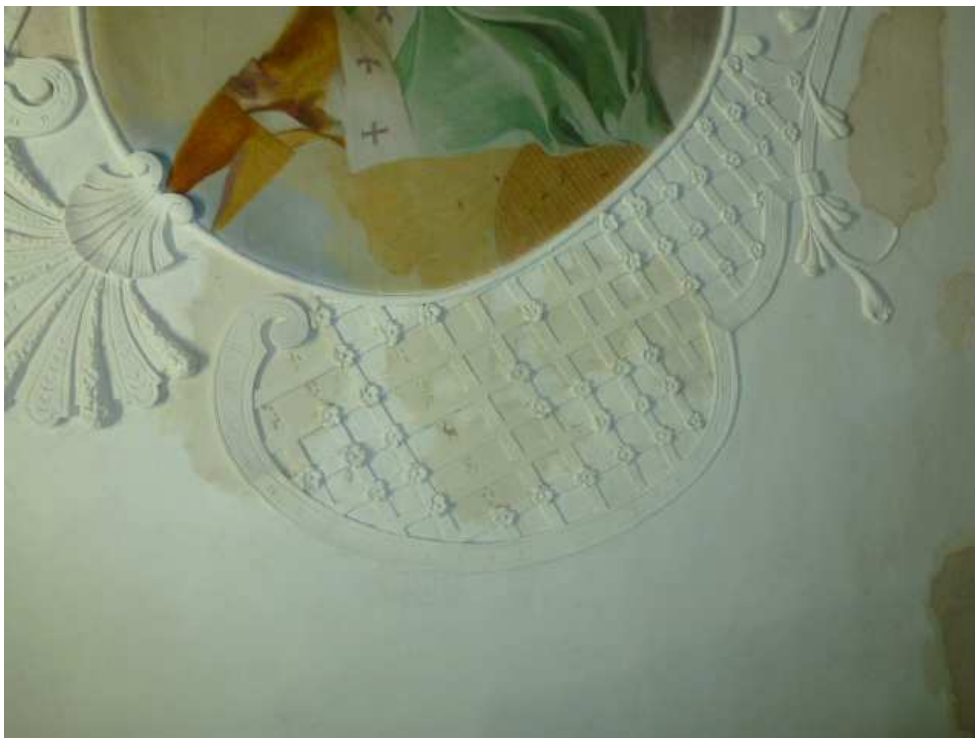
Abb. 5.8: Ansetzen der fehlenden Blumen
