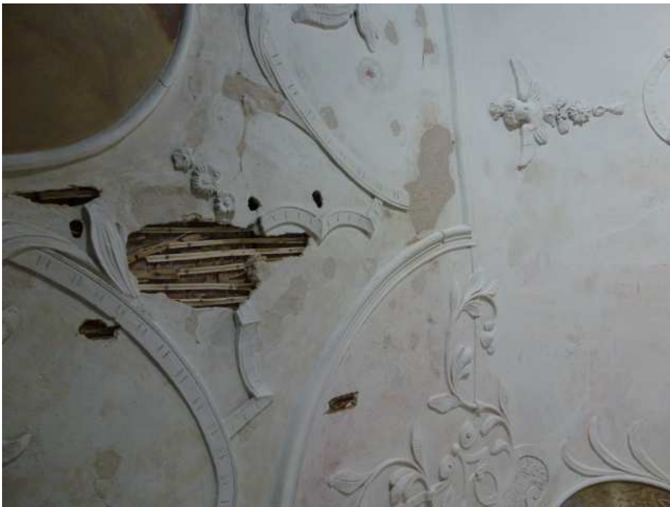
Abb. 2.2: Ergänzte Putzträger (gespaltene Weidenruten)
