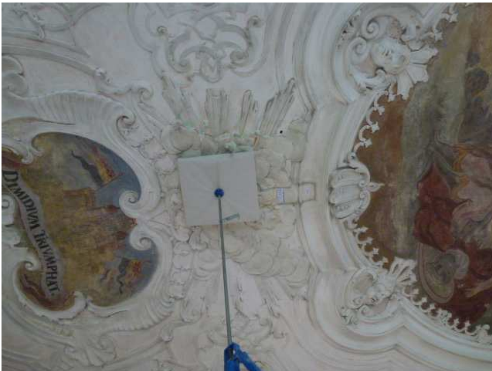
Abb. 1.6: Hohlstellen: Verfüllen mit PLM-A
