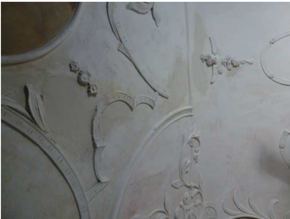
Abb. 2. 14: Antrag der Fehlstellen im Stuck
