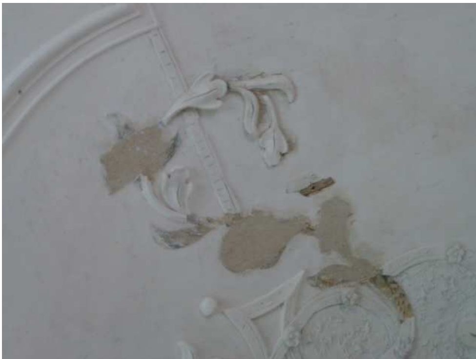
Abb. 4.10: geschlossene Fehlstellen
