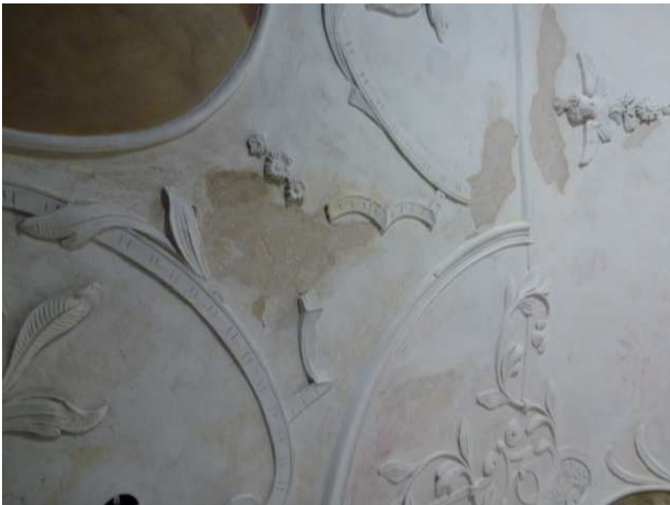
Abb. 2.6: geschlossene Fehlstelle
