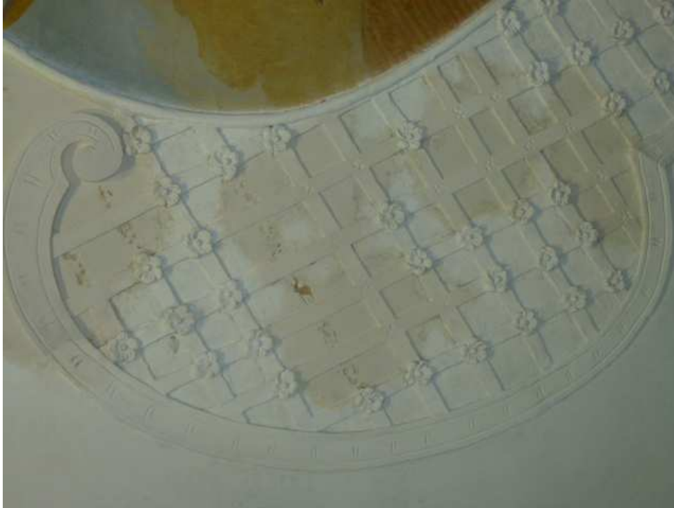
Abb. 5.9: Ansetzen der fehlenden Blumen
