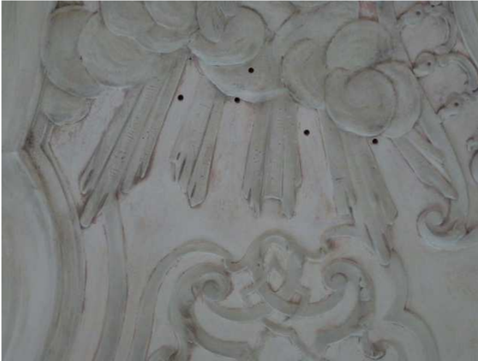
Abb. 1.1: Bohrlöcher für Hinterfüllung
