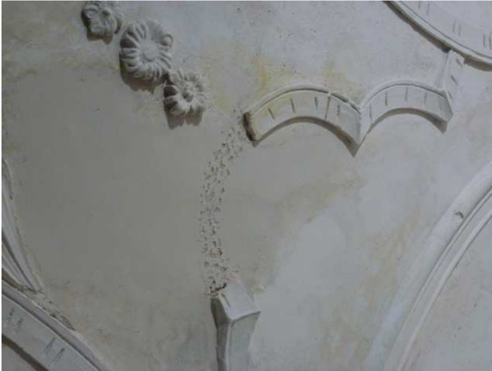
Abb. 2.13: Fehlstelle Bandlstick
