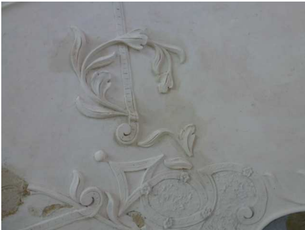
Abb. 4.12: Stuckergänzung unter Verwendung der abgenommenen Teile
