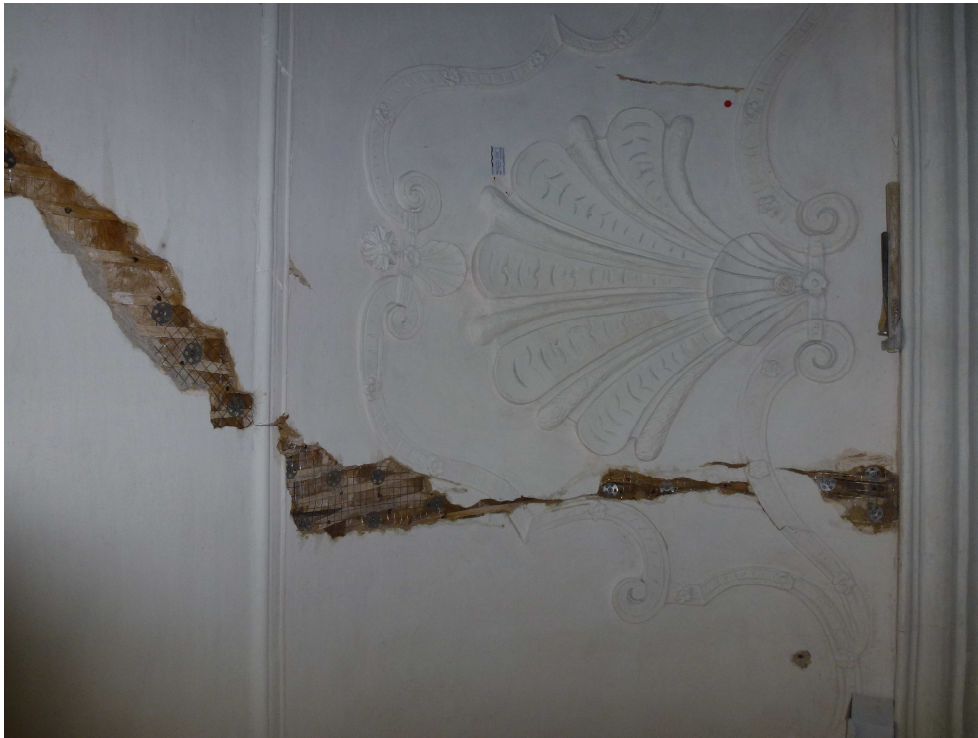
Abb. 3.1: Verstärkte Rissarmierung
