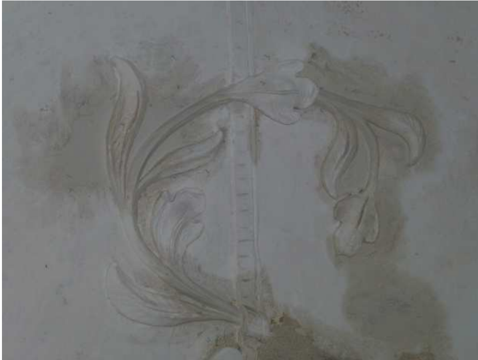
Abb. 4.11: Stuckergänzung unter Verwendung der abgenommenen Teile
