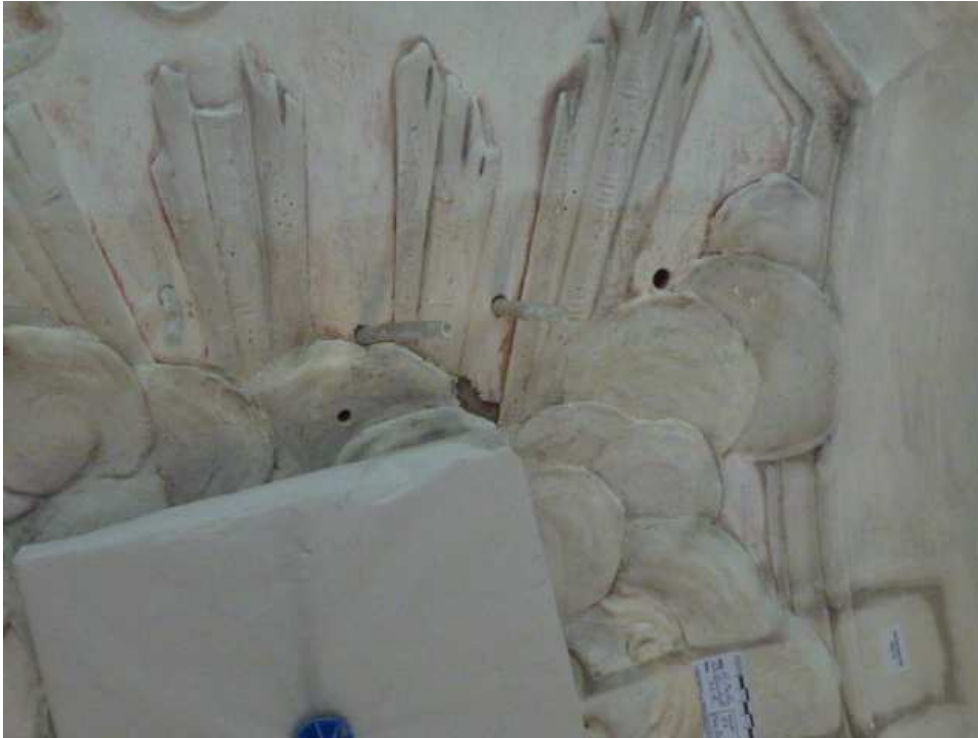
Abb.1.5: Hohlstellen: Verfüllen mit PLM-A
