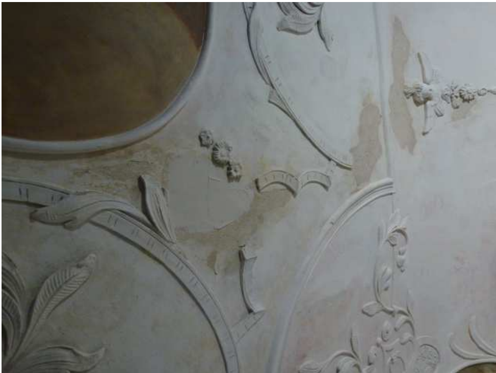
Abb. 2.8: Auftrag der Kalkglätte
